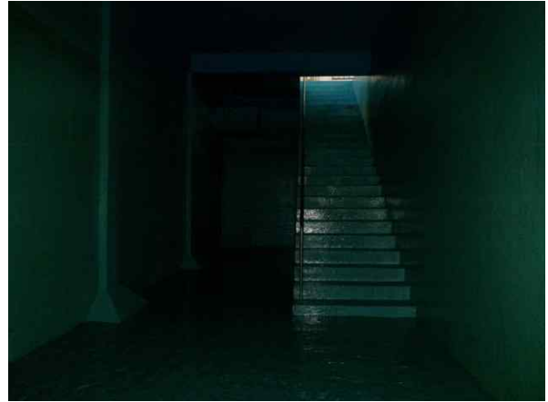
<배수지 2지 전경>
