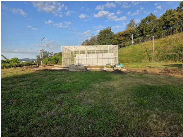
<배수지 상부 전경>
