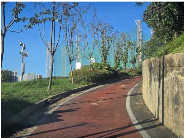
<진입로 포장 전경>
